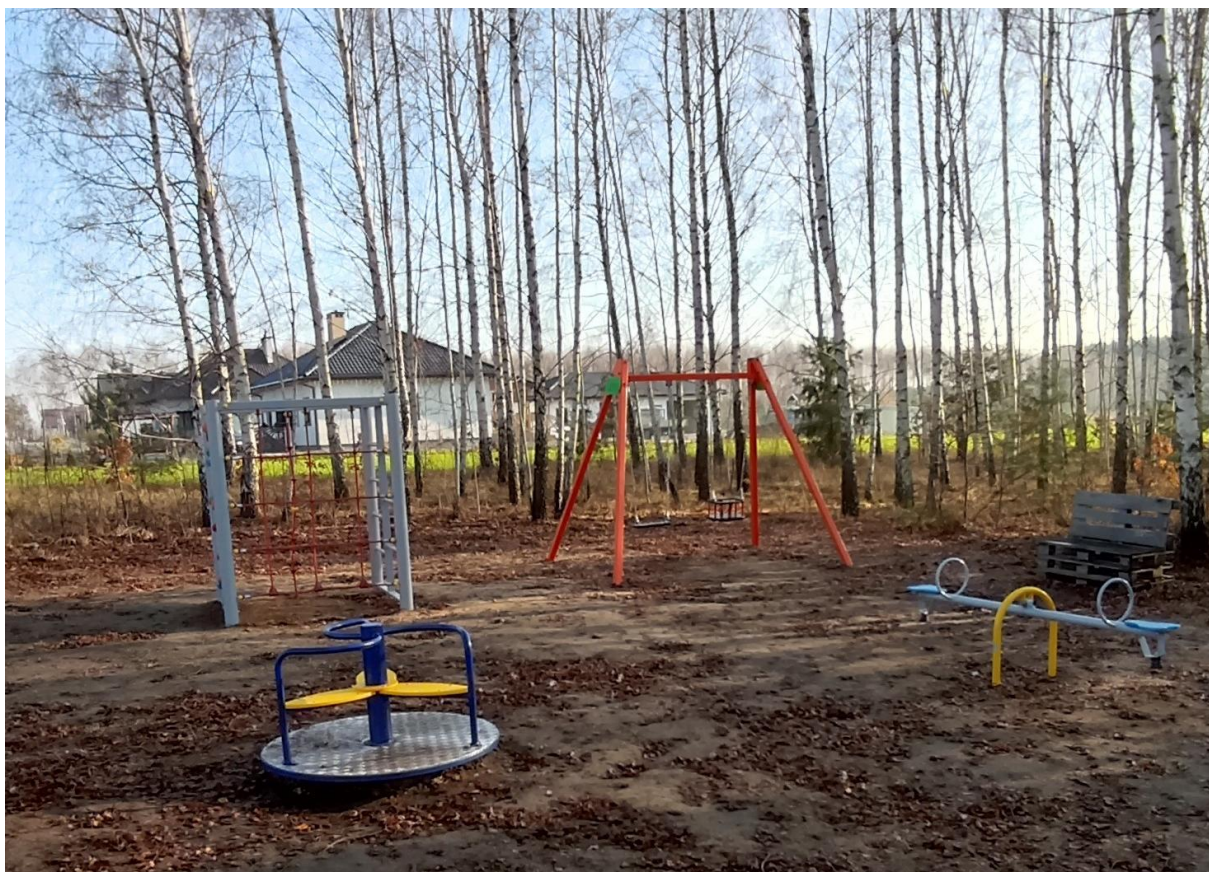
Zdjęcie przedstawiające budowę placu zabaw w Chronowie-Kolonii.
