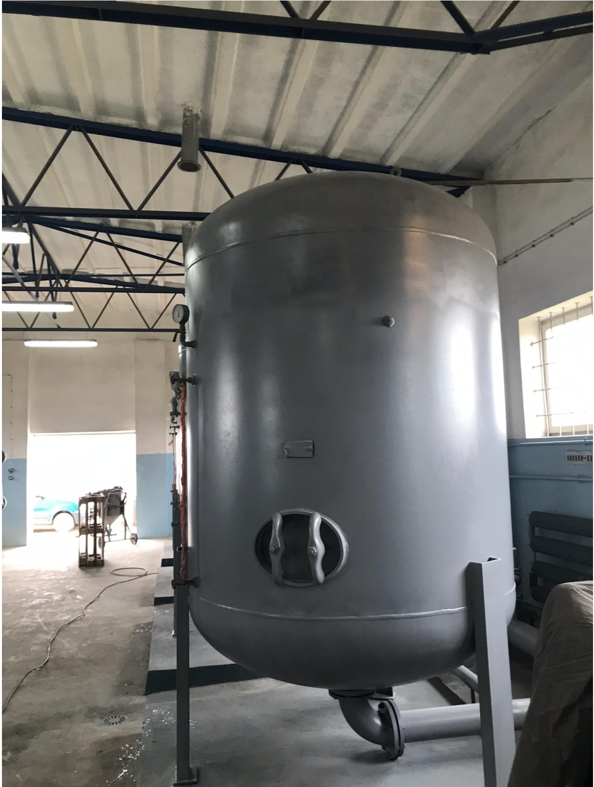
Zdjęcie przedstawiające wyremontowaną hydrofornię w Chronowie.
