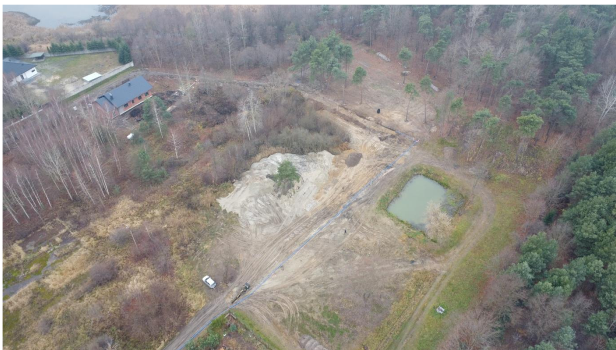
Zdjęcie przedstawiające budowę sieci wodociągowej na terenie byłego SKR w Orońsku.
