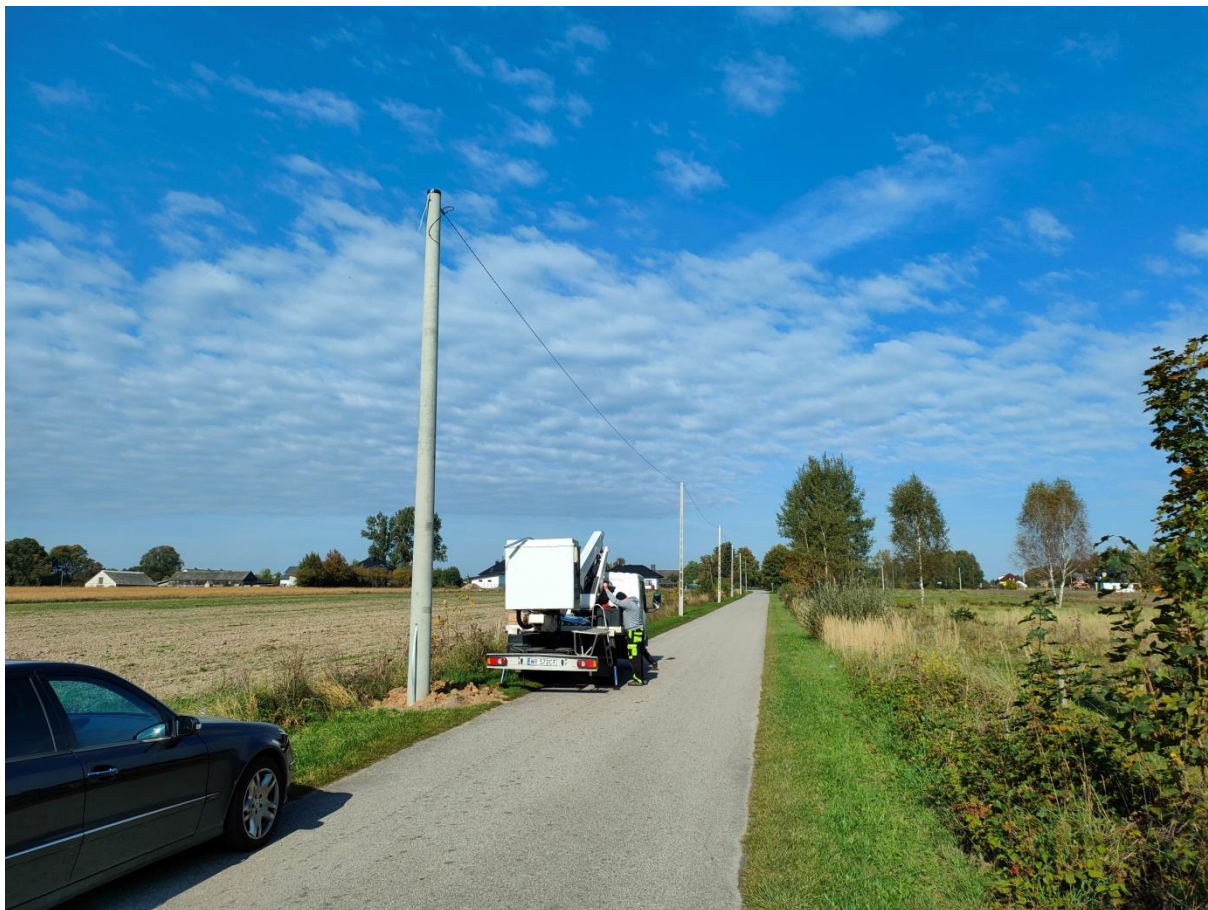
Zdjęcie przedstawiające budowę linii oświetlenia ulicznego w Ciepłej.
