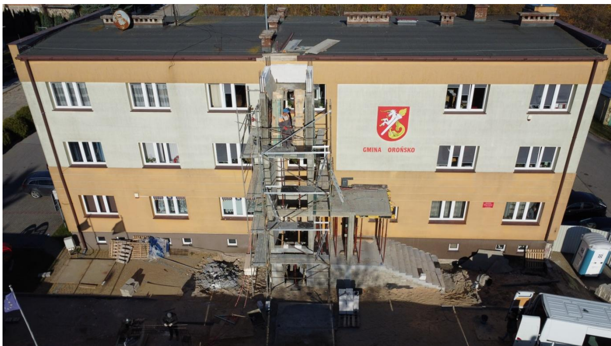
Zdjęcie przedstawiające przebudowę budynku Urzędu Gminy o windę zewnętrzną.
