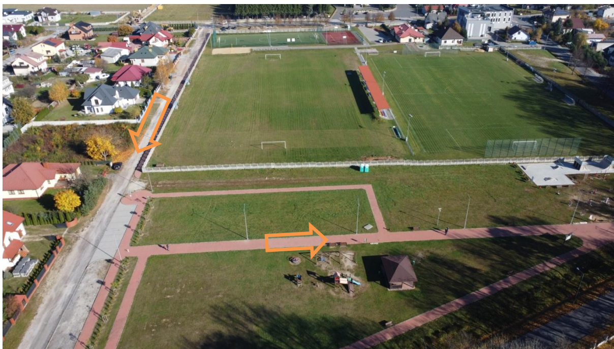
Zdjęcie przedstawiające budowę oświetlenia na terenie Centrum Rekreacji w Orońsku (pomarańczowa strzałka – kierunek budowania linii oświetlenia).
