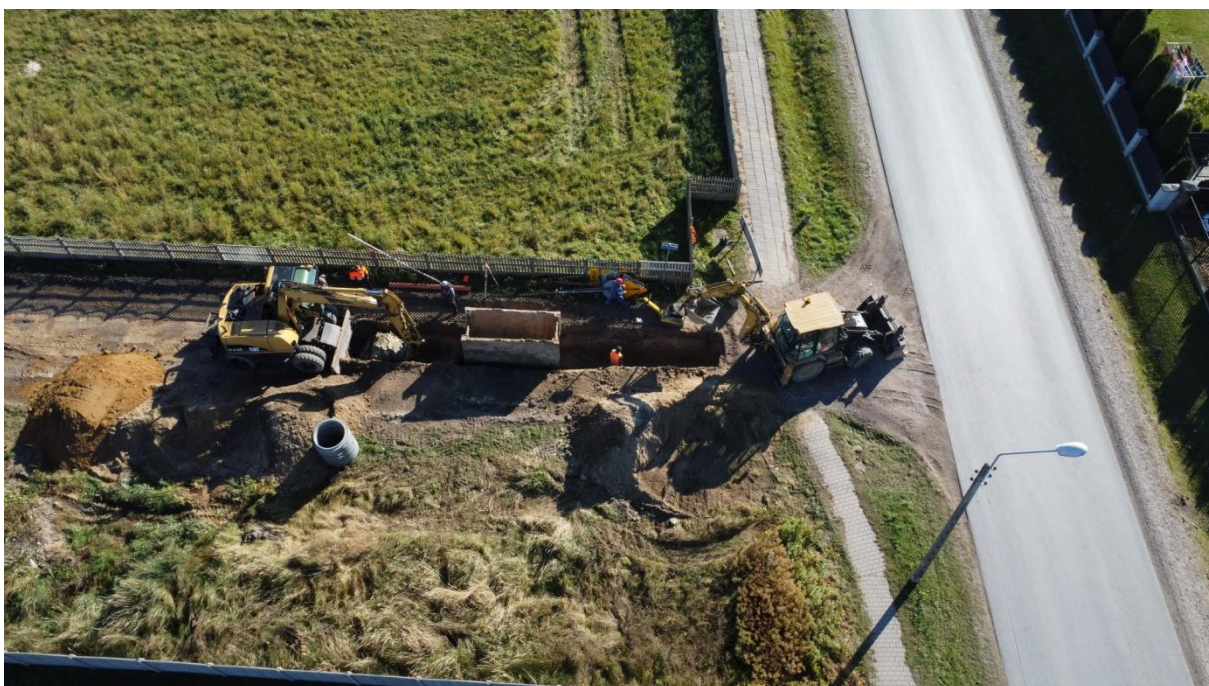
Zdjęcie przedstawiające budowę kanalizacji przy ul. Dworskiej w Orońsku.
